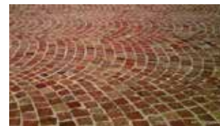
Espesor del adoquín DE 8 a 11 cm.
